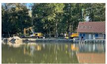
Der Uferbereich von der Wachstation bis zur ehemaligen Sprunganlage wird aktuell zurückgebaut. Die Stadt ließ durch eine Tiefbaufirma die Spundwände entfernen und den Strandbereich anpassen. Durch diesen Rückbau soll der Charakter einer Badestelle entstehen.
